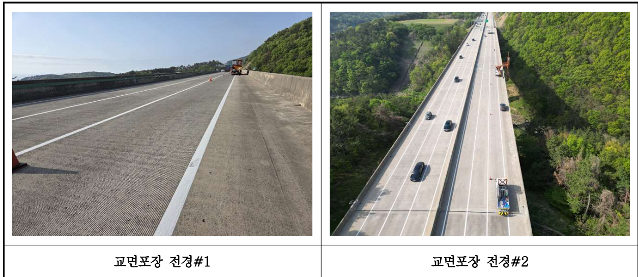
【사진 42.3.20】 교면포장 전경
