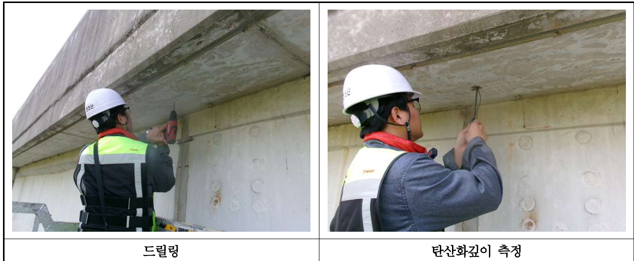
【사진 42.4.3】 탄산화 깊이 측정 현장사진
