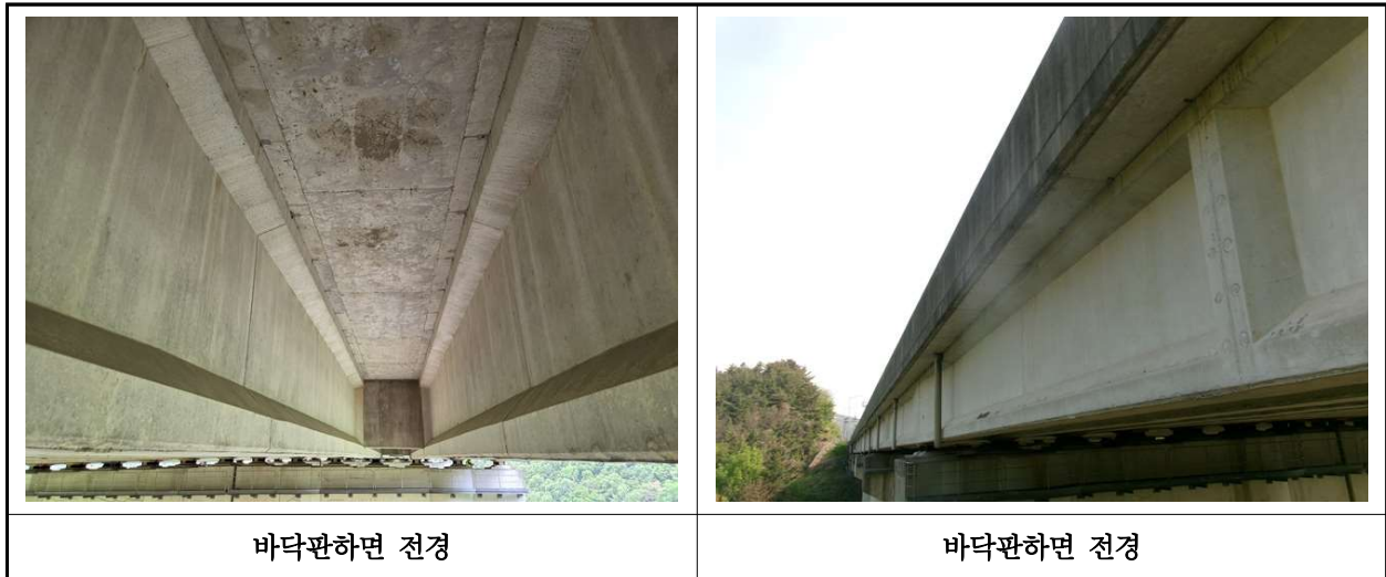
【사진 42.3.2】 바닥판하면 전경
