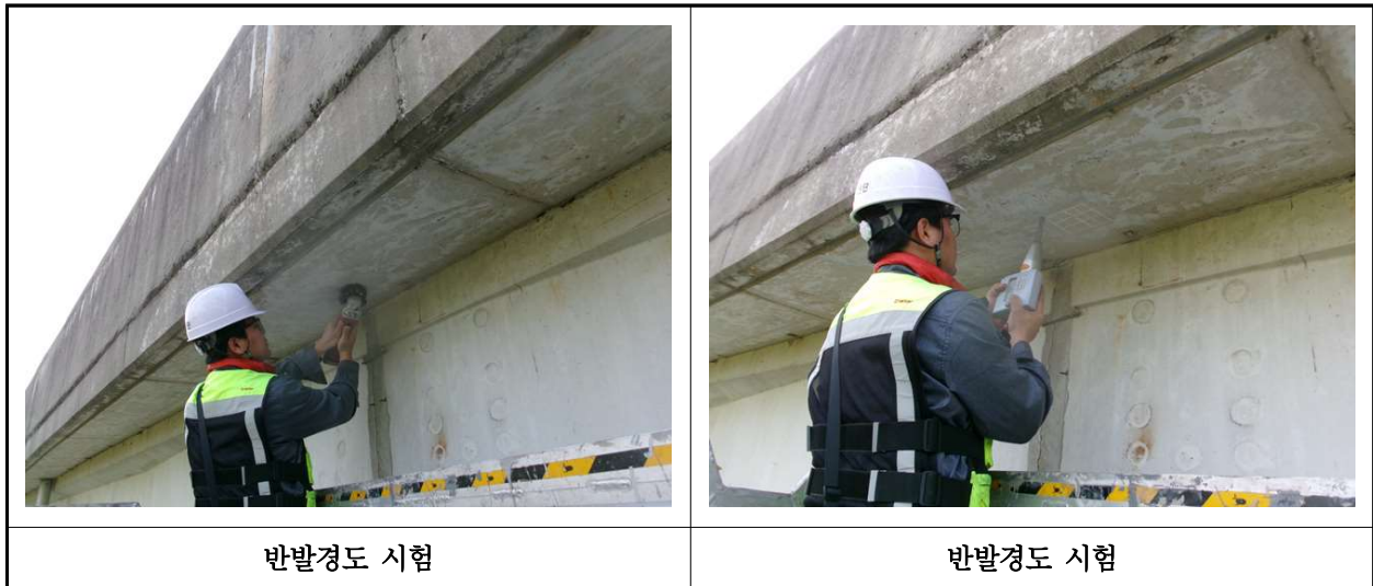
【사진 42.4.2】 반발경도시험 현장사진
