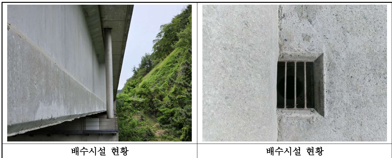
【사진 42.3.22】 배수시설 전경
