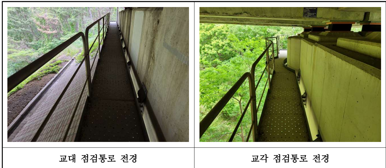
【사진 42.3.26】 교량 점검시설 전경
