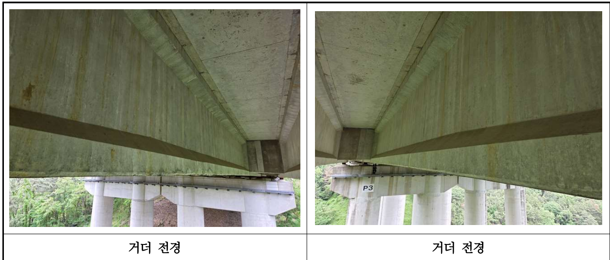
【사진 42.3.4】 거더 전경
