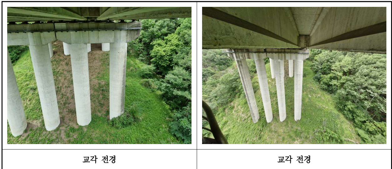
【사진 42.3.10】 교각 전경
