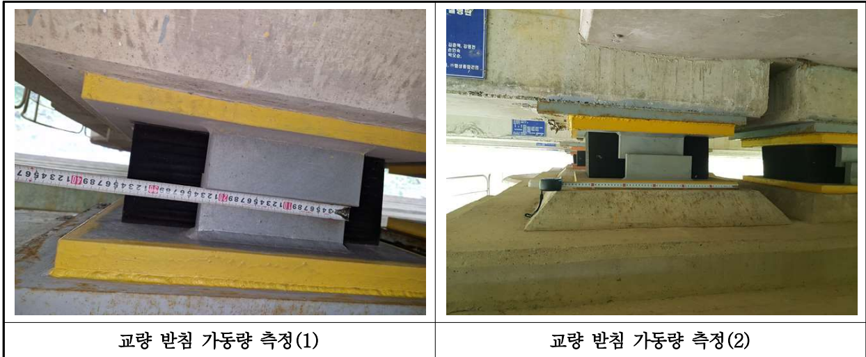
【사진 42.3.16】 교량받침 이동량 측정
